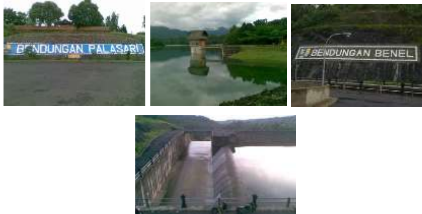
Gambar 11.5 Bendungan di Kabupaten Jembrana
